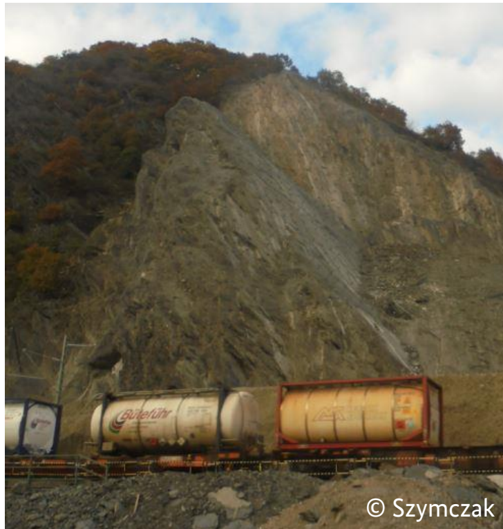
März 2021: Felssturz bei Kestert
