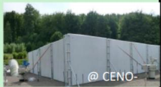
**CENO TEC:** Zweischalige, aufblasbare Lärmschutzwände aus Kunststoff Membranen erreichen eine fast mit Betonwänden vergleichbare Wirkung.
