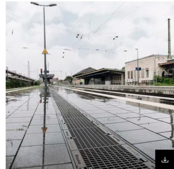
Filterrinnen Drainfix Clean RNC auf dem Bahnhof in Mannheim Käfertal
